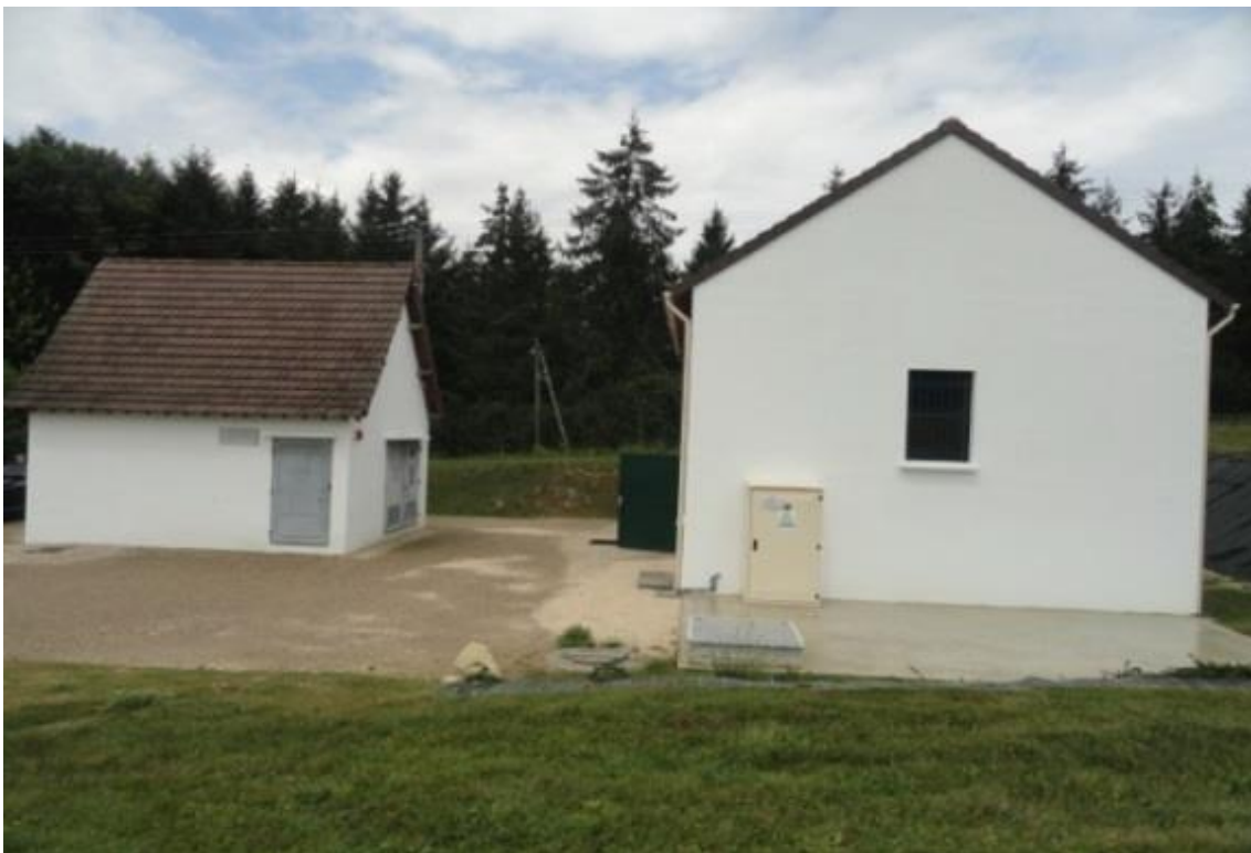
Figure 13 : Photographie de l'unité de traitement de Rosay (source : SIRYAE)
